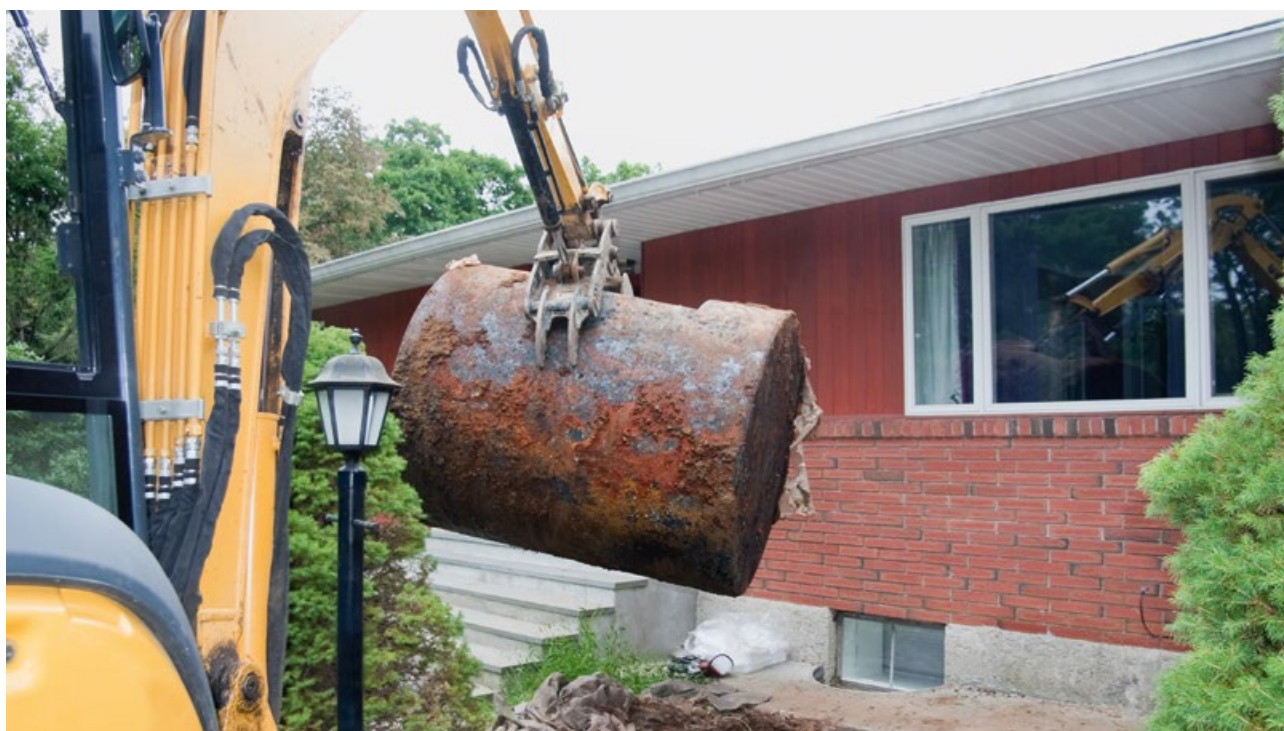
Die Demontage und Entsorgung der alten Ölheizung inklusive Öltank wird gefördert.
